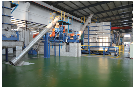
天瑞生产线 制浆车间 大图片
